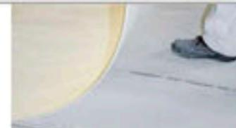
раза. Так, самый распространенный гипсокартон толщиной 12,5 мм во влажном состоянии способен изогнуться до радиуса 1000 мм, а арочный гипсокартон КНАУФ изгибается до радиуса 300 мм.
